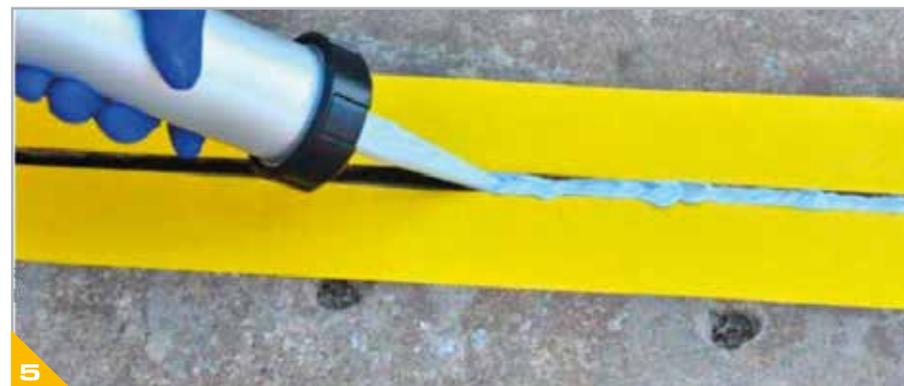
Colocar la boquilla en la junta preparada. La boquilla debe tocar ligeramente el fondo de junta.
