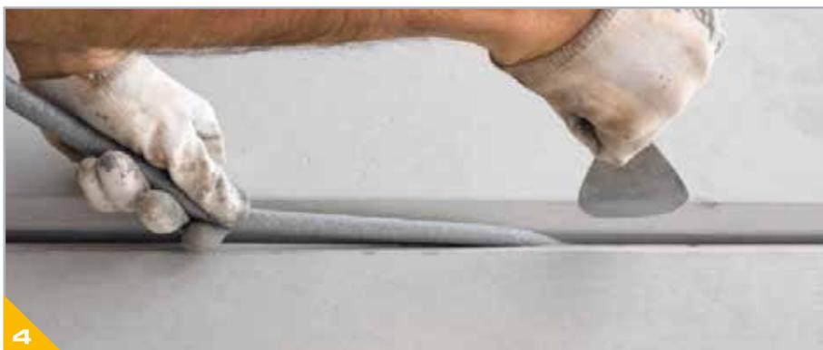
Para mantener la profundidad del sellador recomendada, hay que colocar un fondo de junta antiadherente, evitando estirar. El diámetro del fondo de junta debe ser unos 3 mm mayor que la anchura de la junta de dilatación.
